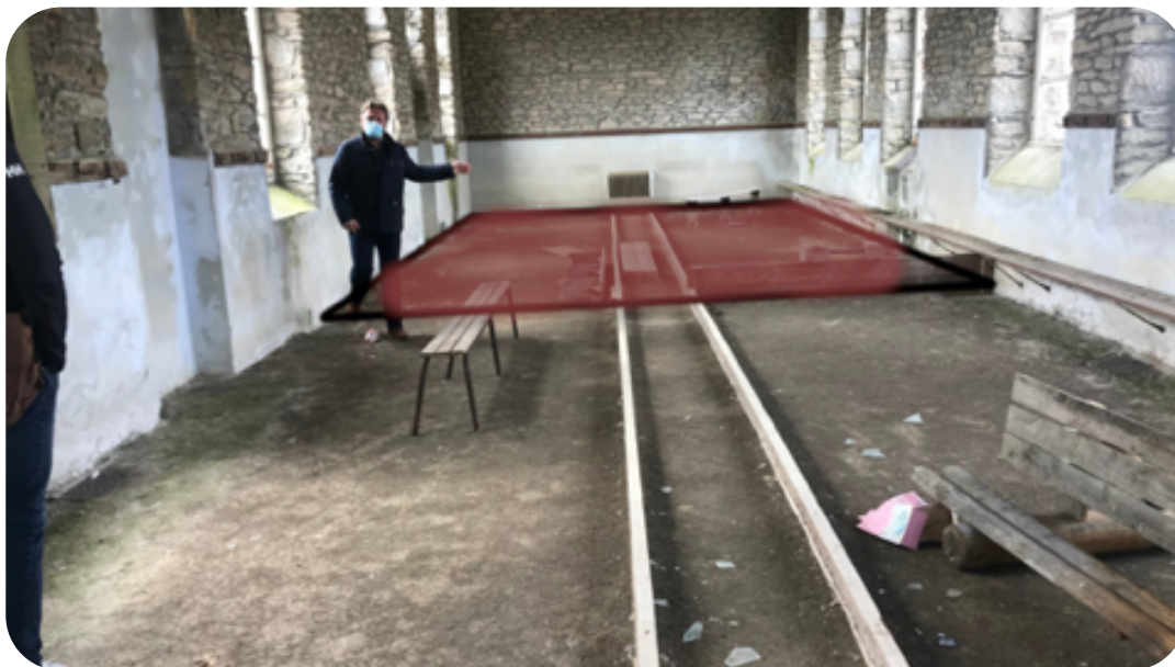
Espace fablab prévu dans la future médiathèque/travaux en cours
