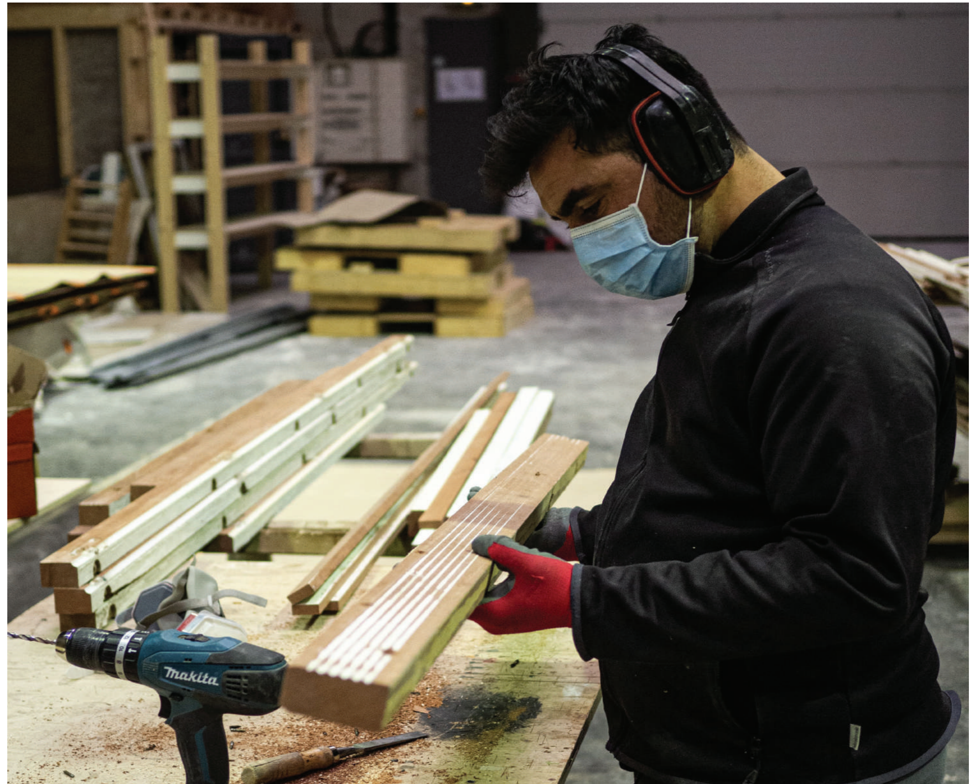
Dépollution d'anciennes menuiseries de fenêtre provenant d'un immeuble Haussmanien rue du Bac© Pimp Your Waste
